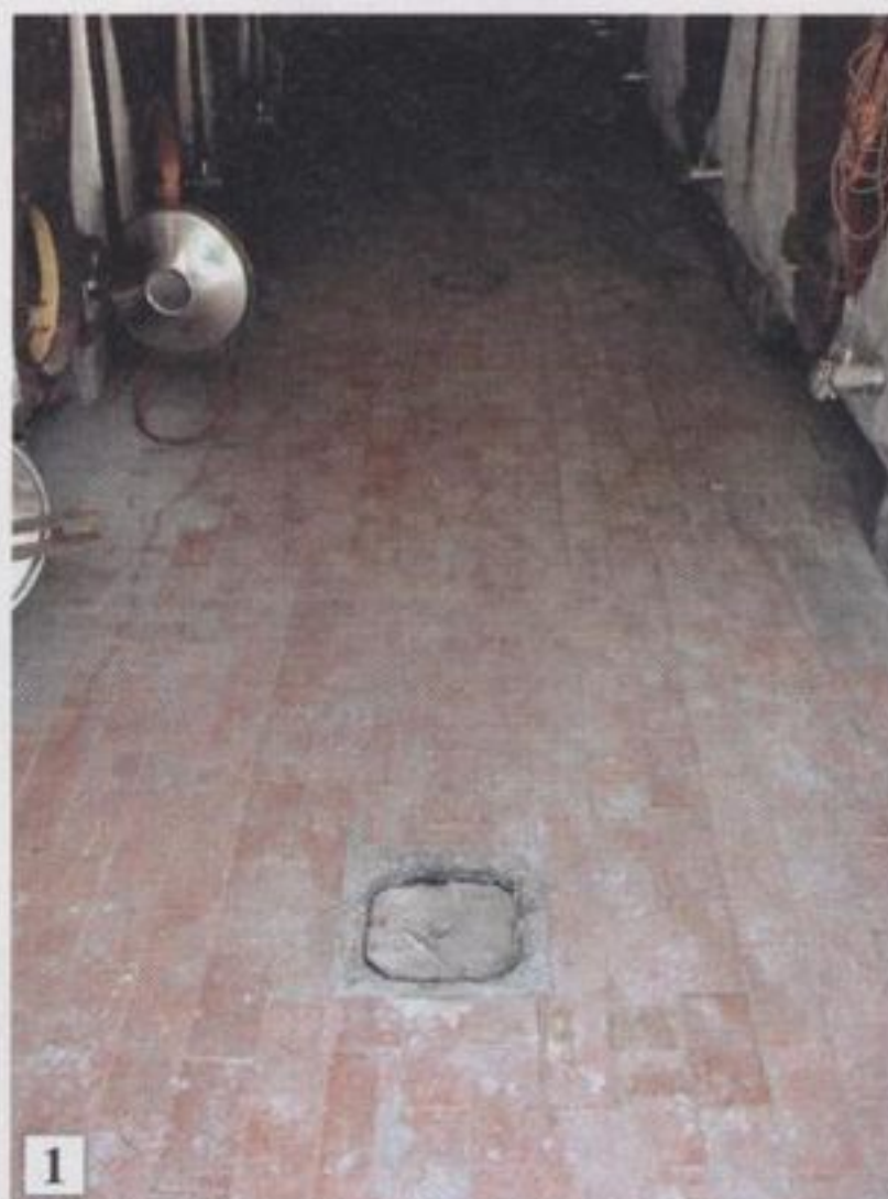
Il pavimento di una cantina prima (1) e dopo (2) gli interventi di manutenzione con la realizzazione di adeguate pendenze, la posa di una canalina centrale per lo scolo delle acque di lavaggio e la sostituzione delle piastrelle con resine epossidiche
