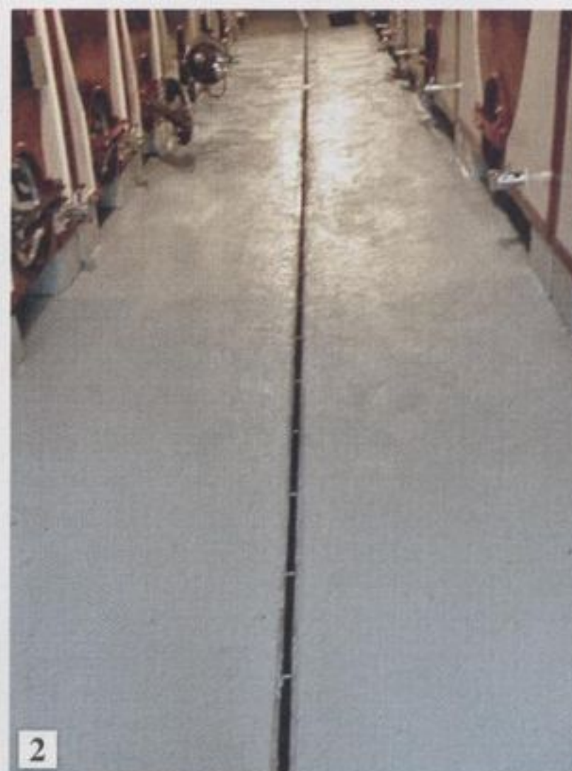
Il pavimento di una cantina prima (1) e dopo (2) gli interventi di manutenzione con la realizzazione di adeguate pendenze, la posa di una canalina centrale per lo scolo delle acque di lavaggio e la sostituzione delle piastrelle con resine epossidiche
